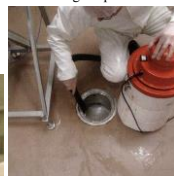
Kanalisatsiooni trappe peab olema võimalik kergesti puhastada
